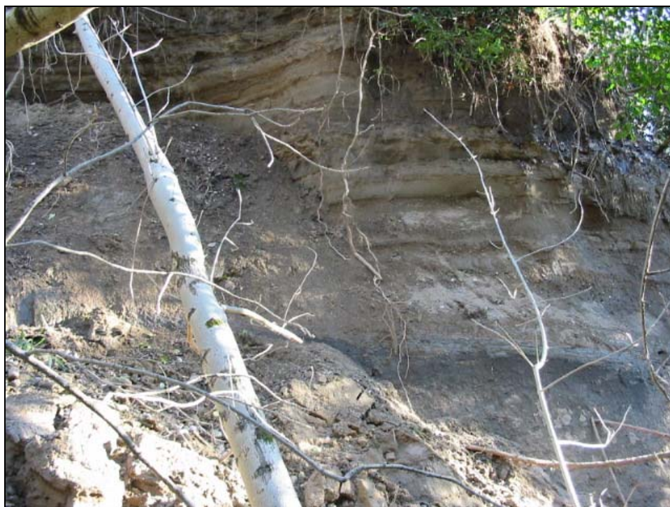
AFFIORAMENTO DI ARGILLE VILLAFRANCHIANE LUNGO LA TESTATA DELLE ROGGIA CASANOVA LANZA NELLE VICINANZE DEL DISSESTO DELLA FOTOGRAFIA PRECEDENTE
