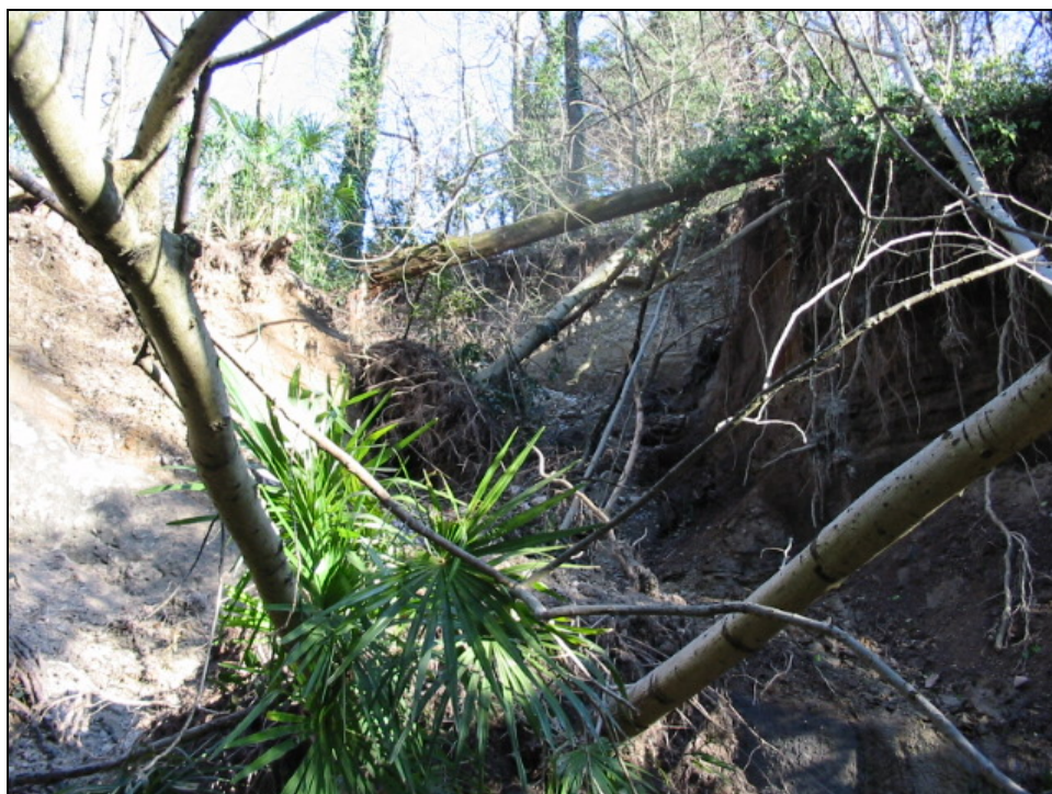
DISSESTO LUNGO LA TESTATA DELLA ROGGIA CASANOVA LANZA (QUOTA DELLA NICCHIA 400 m s.l.m.)
