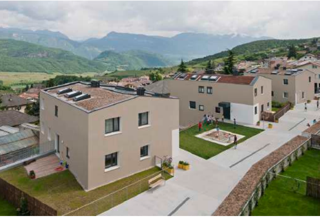
Feld72, Complesso residenziale a Caldoro (BZ), 2010
